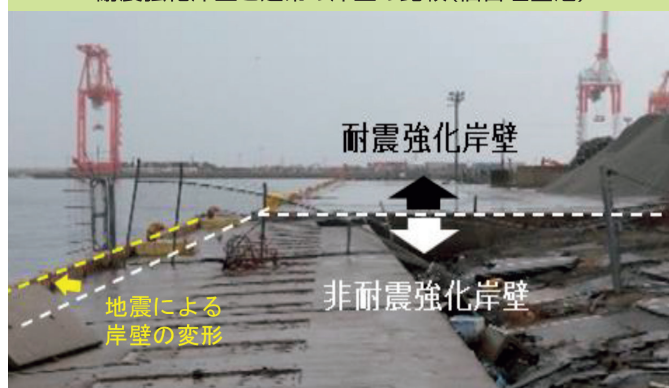
耐震強化岸壁と通常の岸壁の比較(仙台塩釜港)
