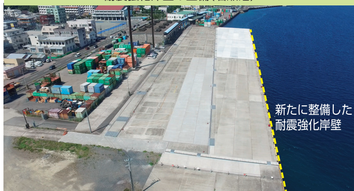
耐震強化岸壁の整備(名瀬港)
