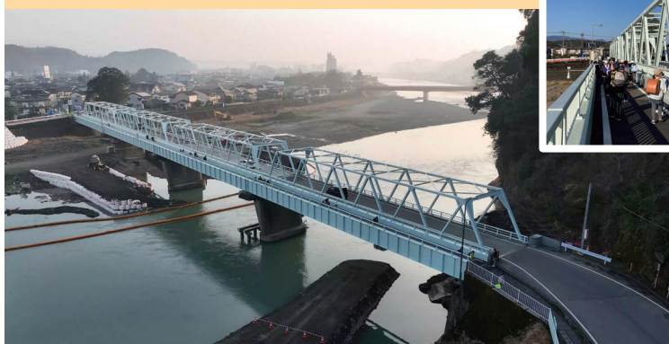
西瀬橋架替完了（R5.2時点）
