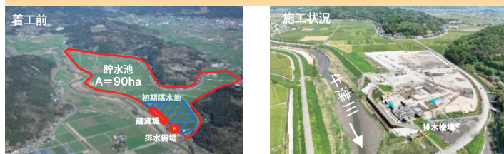
牛津川遊水地の施工状況
