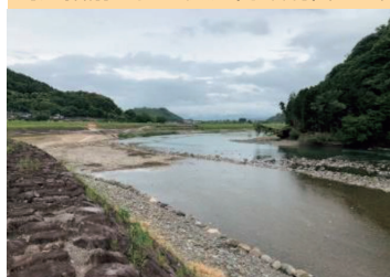
河道掘削の施工状況(球磨村)(R5.6)
