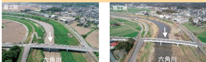
河道掘削の施工状況
