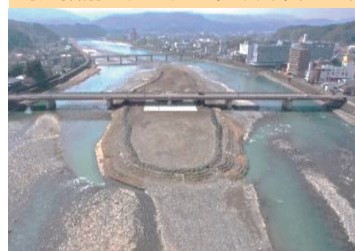
河道掘削の施工状況(人吉市)(R5.3)
