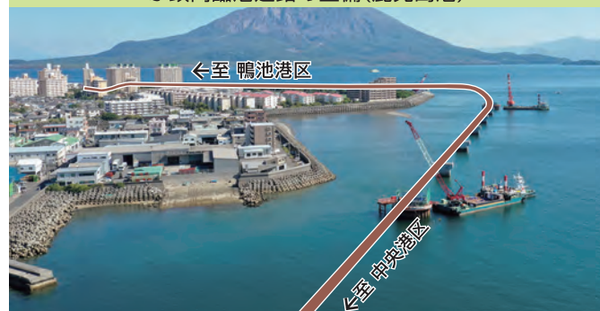
港湾物流のボトルネック解消のためのふ頭間臨港道路の整備(鹿児島港)
