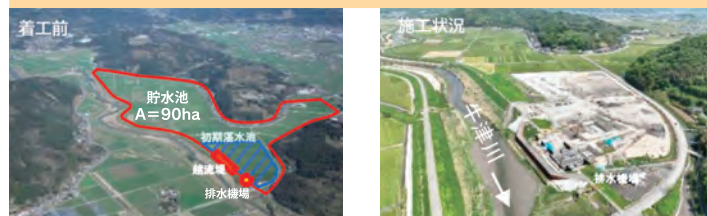
牛津川遊水地の施工状況
