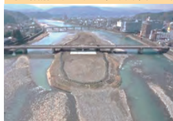
河道掘削の施工状況(人吉市)(R5.3)
