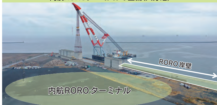
ドライバー等の人手不足や労働規制に対応した内航ROROターミナルの整備(大分港)
