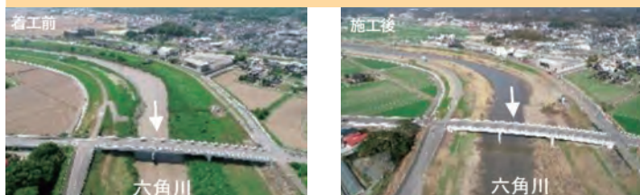
河道掘削の施工状況
