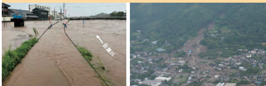
筑後川水系巨瀬川の被害状況（令和5年7月10日）
