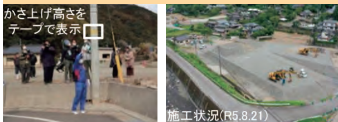
輪中堤・宅地かさ上げ事業：球磨村神瀬地区
