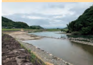
河道掘削の施工状況(球磨村)(R5.6)
