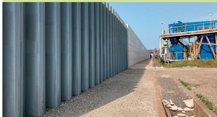
護岸整備状況(大分港海岸)
