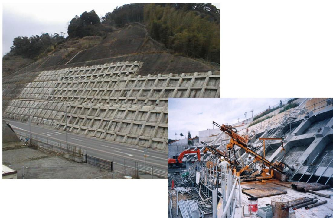
図 2-22 グラウンドアンカー工におけるのり枠工(例)
