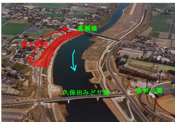
[新田地区築堤（嵩上げ）]
