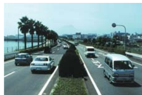
亀川バイパス 4車線化
