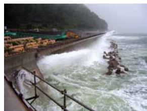
※新技術「フレア(非越波型)護岸」の採用(東別府~うみたまご区間) ⇒大規模な道路工事では日本初の工法
