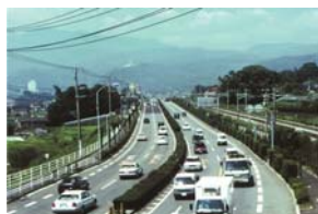
日出地区 4車線化
