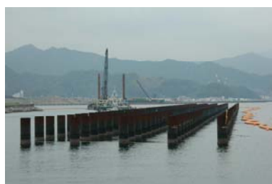
【施工状況 H19.10】
