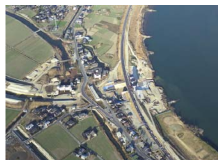
寒水川水門の合流点部分の整備状況
