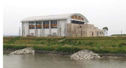
久留米西部河川防災ステーション
