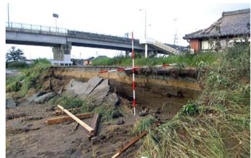
高潮による堤防法崩れ状況 (平成18年台風13号)
