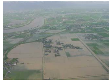
寒水川右岸堤防決壊による浸水被害 (平成13年7月)
