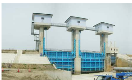
上屋が完了した寒水川水門
