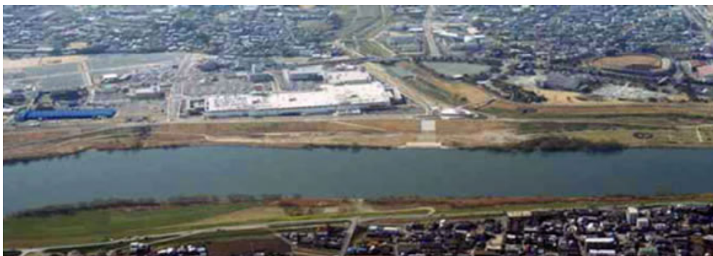
くるめウス周辺状況
