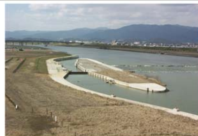
舟運による緊急輸送路の整備
