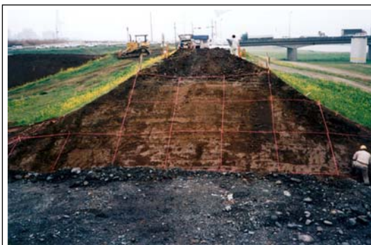
堤防断面の土質構成の事例(久留米市東櫛原)
