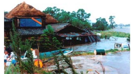
高潮による浸水状況 (昭和60年台風13号)
