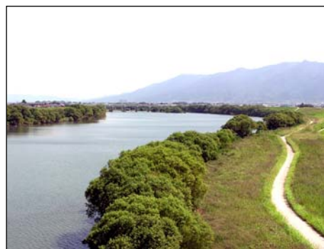
河道内の樹木繁茂状況(久留米市)
