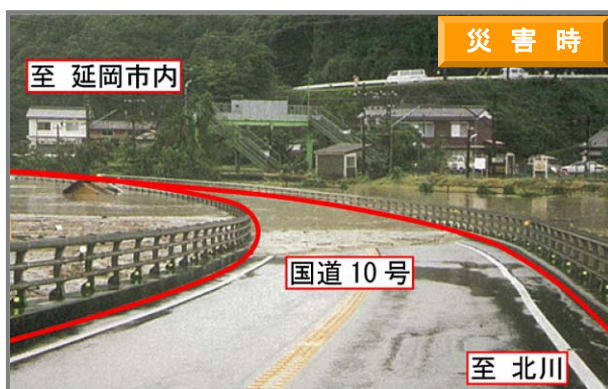
※H9年 台風19号大水害 路面冠水による全面通行止め
