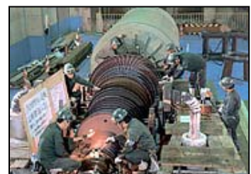
■タービンメンテナンスの様子
