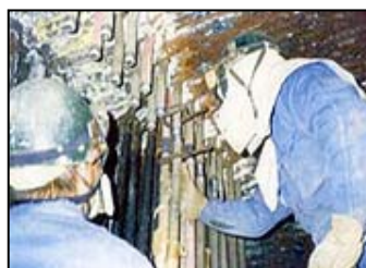
■ボイラーチューブ更新の様子
