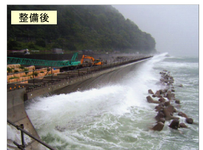
▲ 急傾斜地での施工性の高い構造→フレア護岸
