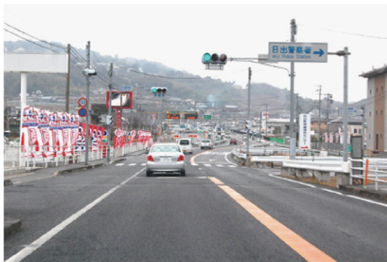
▲ 整備前の国道10号の状況
