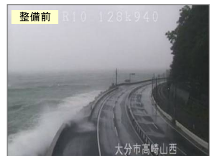
▲ 越波による上下線通行止め時の状況
