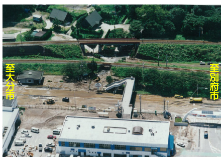
▲ 路面冠水による通行規制時の状況 (H5.9、大分マリンパレス前)
