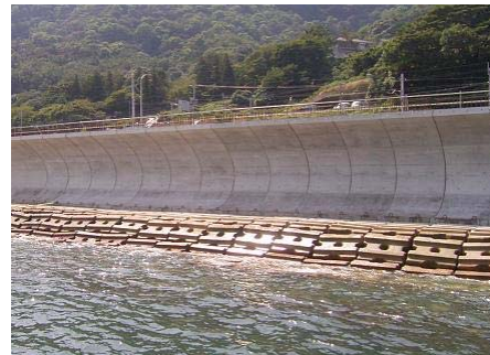
▲フレア護岸施工後の状況
