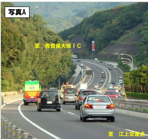
▲スムーズな走行が可能な完成4車線区間
