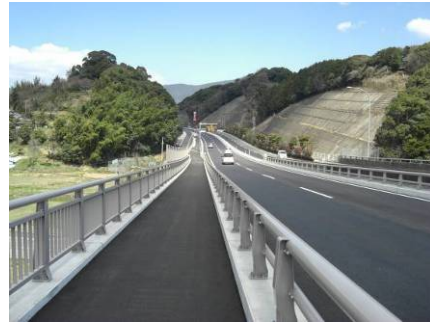
▲ 道路附属物整備の状況
