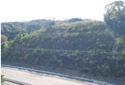
▲ 法面緑化の状況
