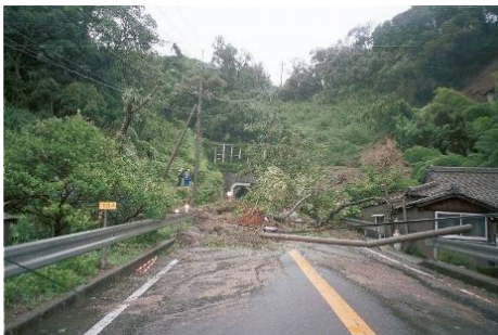
写真①：台風14号（H17）による被害状況 （国道220号海瀾トンネル付近）
