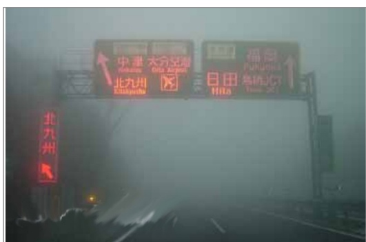
▲ 大分自動車道（日出JCT付近）の濃霧時
