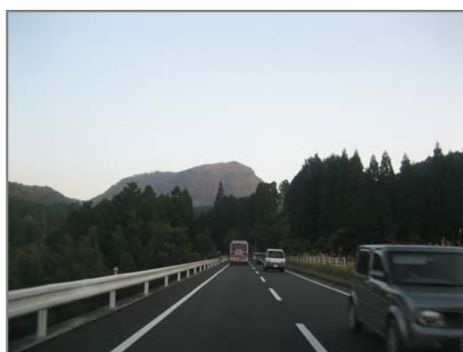
▲ 供用後の状況 (走行性の高い区間：宇佐市院内町温見)
