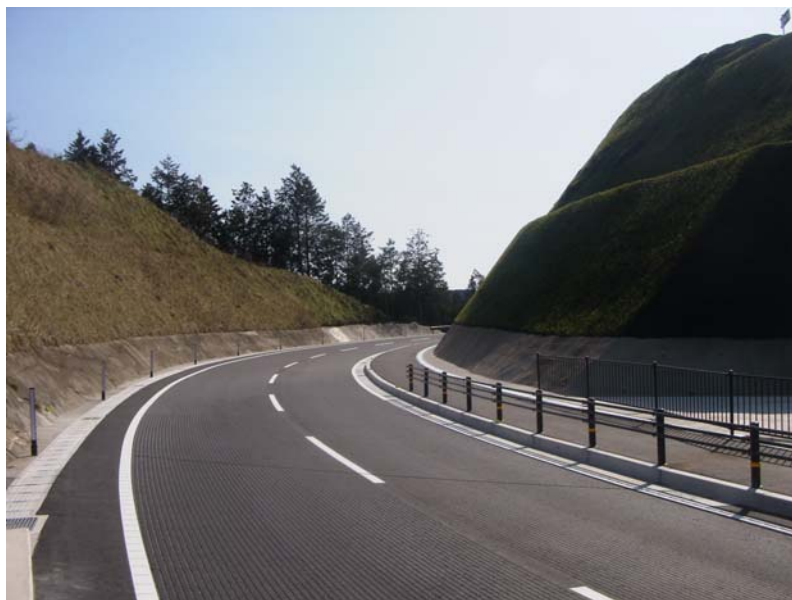
▲ 切土部分の法面の状況 (宇佐市院内町野地地区付近)
