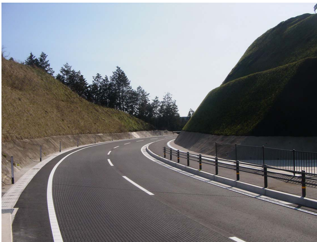
▲ 切土部分の法面の状況（宇佐市院内町野地地区付近）
