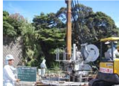
▲ 硬質地盤クリア工法の施工状況
