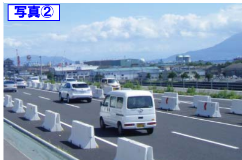
▲ 3/4 車線部分暫定共用状況
