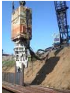
▲ バイブロハンマ工法の施工事例
