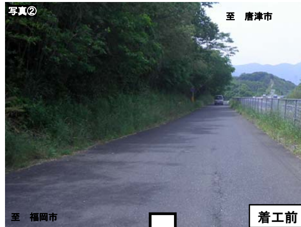
東地区切土工事状況(H28.8完成)
