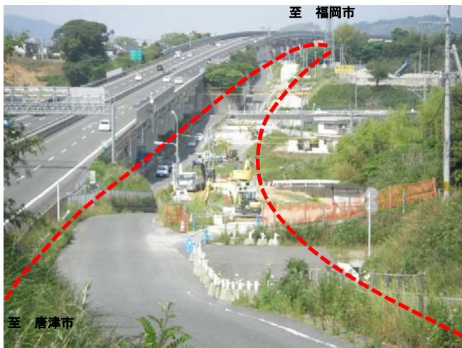
写真①:切土盛土工事(本線下り線 富地区)
