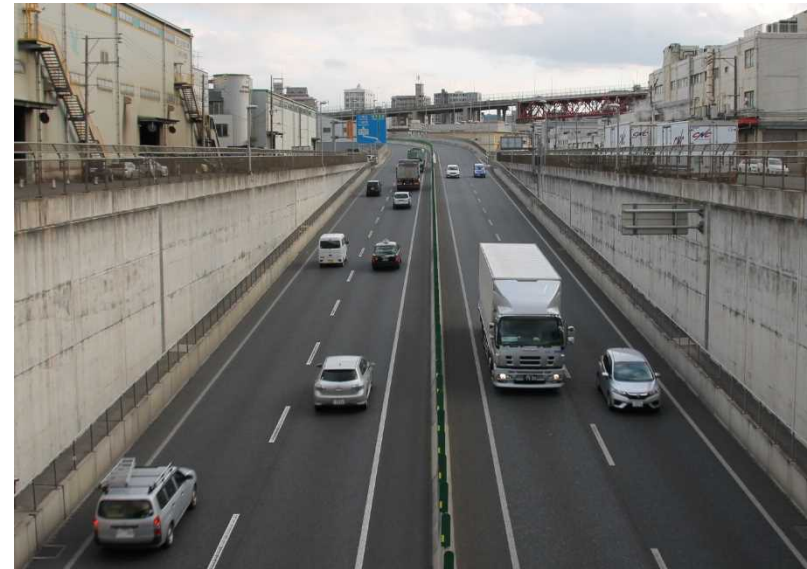
▲ 新若戸道路利用状況 (戸畑区側)
