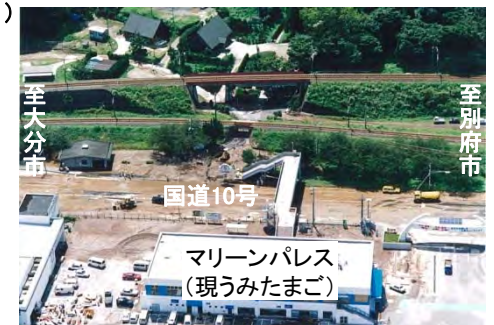
▲路面冠水による通行規制時の状況(H5.9大分マリンパレス(現うみたまご)前)
