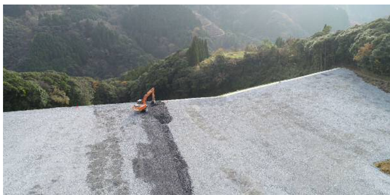
▲折原地区盛土状況
