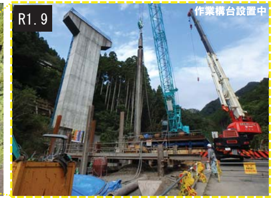
▲【寺山一号橋(近景)】
