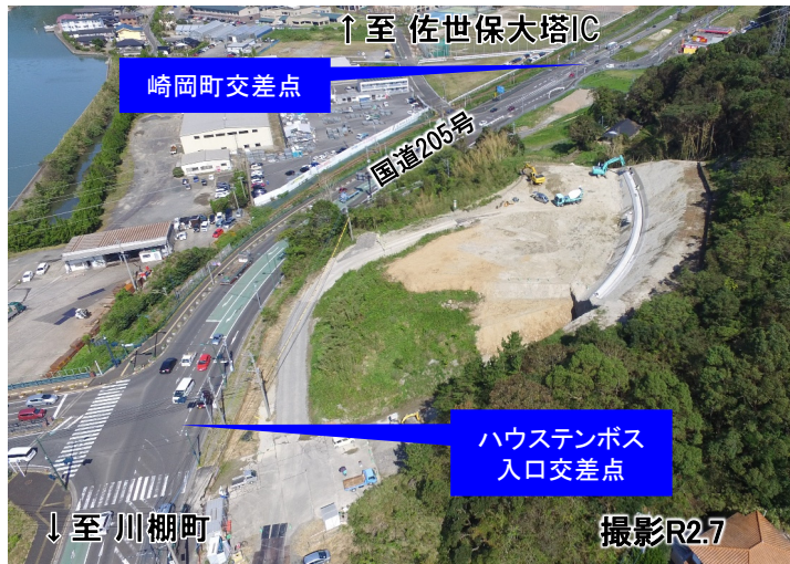
▲ 写真① 崎岡地区の工事状況
