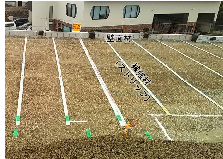
▲写真 補強土壁の施工状況
