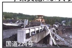
図6 土石流被害事例(野尻川)
