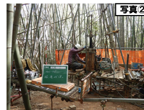
▲ 地質調査の実施状況
