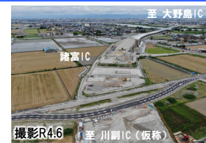
▲諸富IC付近の工事状況
