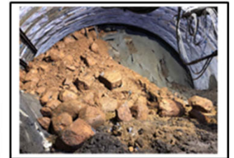
写真② 切羽面崩落
