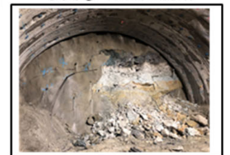
写真② 切羽面崩落
