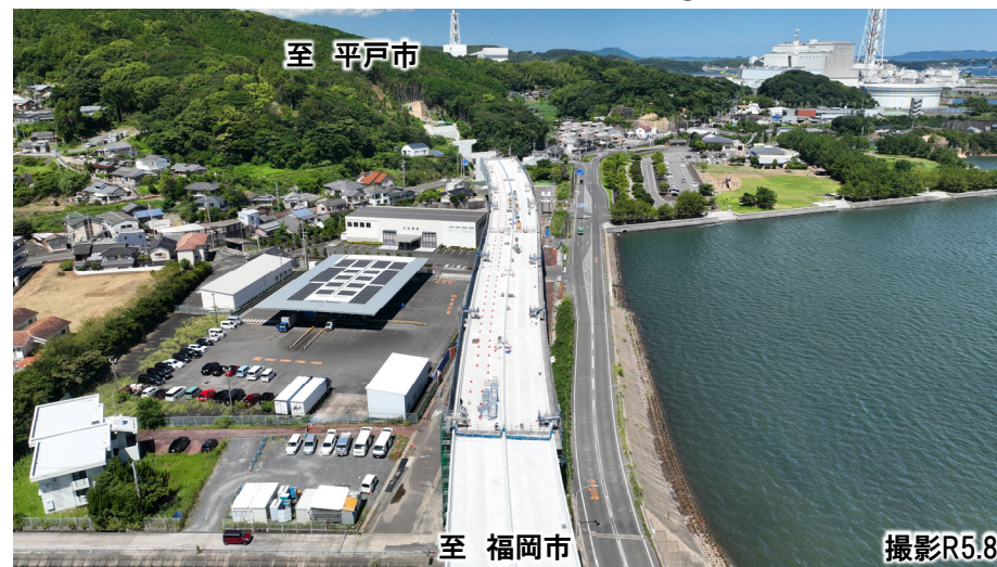
▲松浦4号橋（仮称）施工中（写真③）
