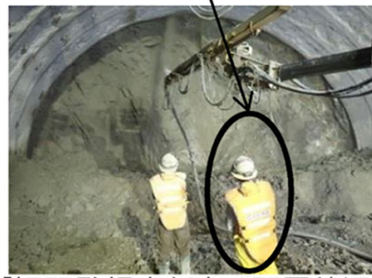
【切羽監視責任者の配置状況】
