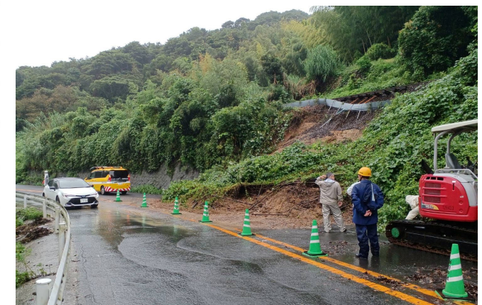
写真② 法面崩落の状況 (松浦市御厨町、R5.9.15)
