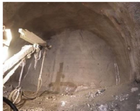
【鏡吹付施工状況】
