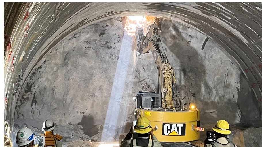
▲松浦2号トンネル（写真①）
