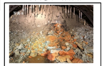
写真② 天端崩落
