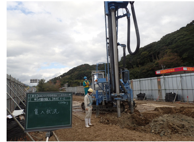
▲ 写真② 崎岡地区の工事状況 (地盤改良)
