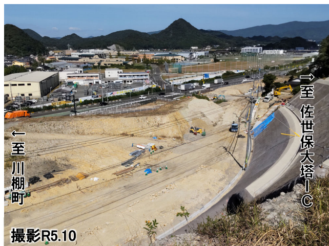
▲写真② 県道付け替え施工状況
