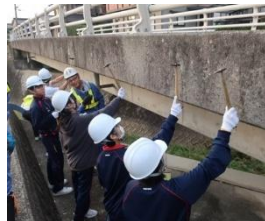
学生による橋梁点検体験
