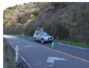
MMS※1を活用した 斜面・のり面点検
