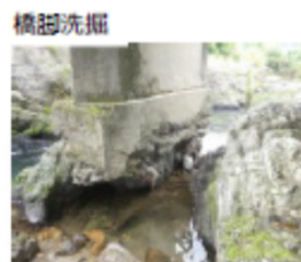
橋脚洗掘 判定区分Ⅳ (緊急に措置を講ずべき状態)
