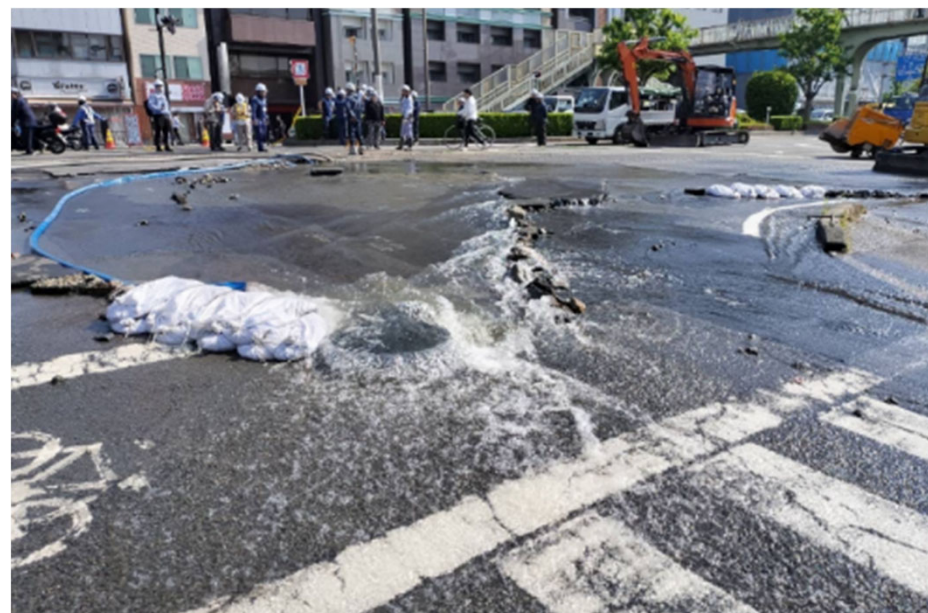
京都市国道1号で発生した漏水事故 (4/30)
