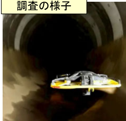
ドローンによる目視調査
