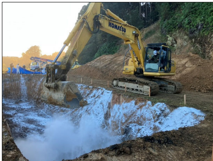
△埋却溝掘削作業状況
