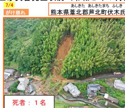
出典：令和 2 年 7 月豪雨による土砂災害発生状況 (2020 年 8 月 21 日 (国土交通省))
