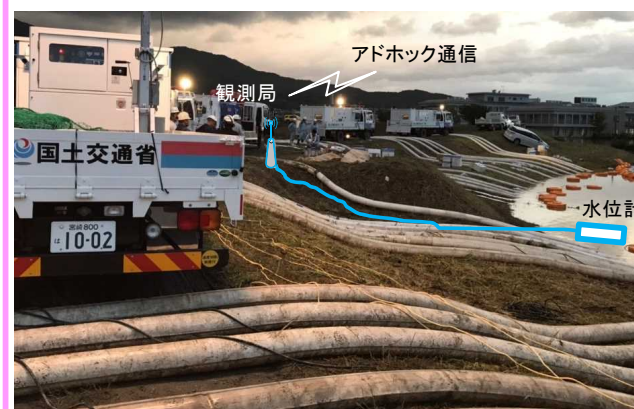
移動式アドホック型水位計の設置イメージ (令和元年8月 佐賀県大町町における排水活動)
