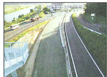
▲ 現道切り回し道路完成状況
