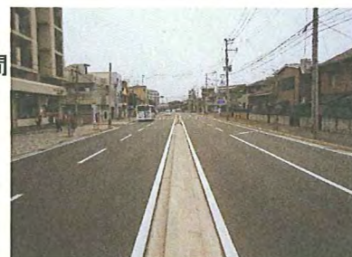
4車線供用区間 完成写真
