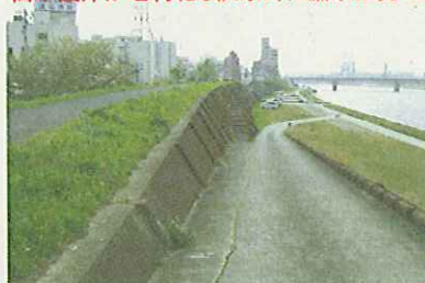
高水護岸が老朽化し洪水時に漏水が発生
