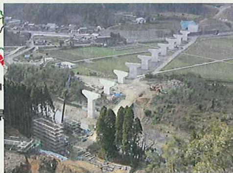
▲青山橋(仮称)施工状況
