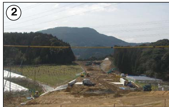
▲施工状況(重橋地区)
