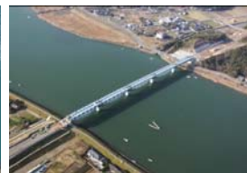
▲川内川橋施工状況 (川内IC～高江IC)
