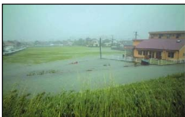
<平成17年9月台風14号出水 中の瀬ポンプ場のある川原崎地区浸水状況>
