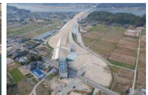
▲高江IC付近施工状況
