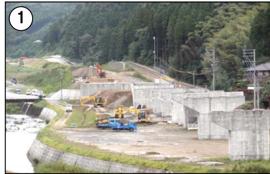
▲施工状況(山彦橋)
