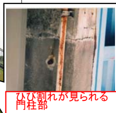
コンクリート表面が剥離し 内部の鉄筋が露出腐食
