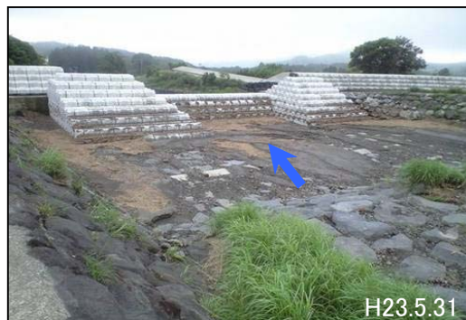
■ 荒川内上流緊急ブロック堰堤(都城)
