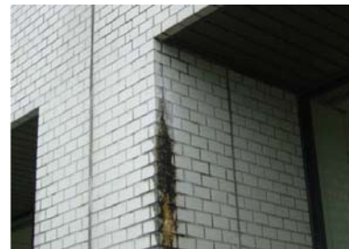
外壁タイル面の状況
