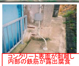
ひび割れが見られる 門柱部
