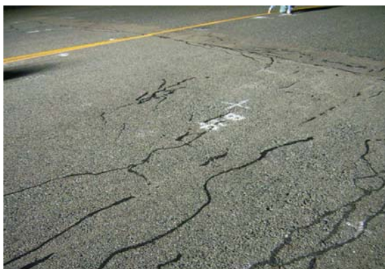
舗装表面の経年劣化によるひび割れの発生
