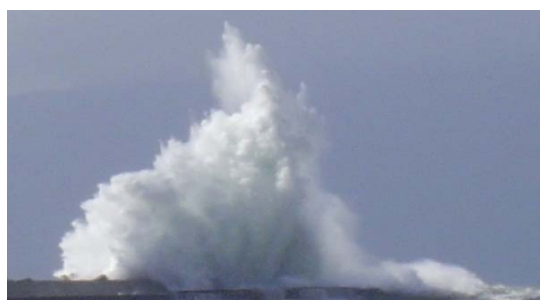
台風来襲時の防波堤状況
