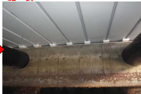
岸壁(棧橋式)の上部における老朽化対策
