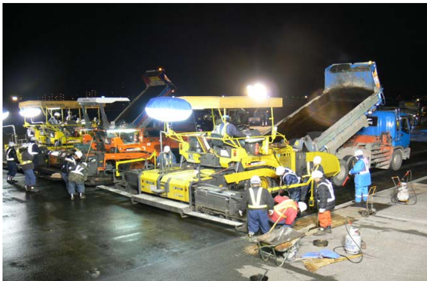
老朽化した舗装の改良
