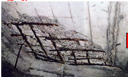
岸壁(棧橋式)の上部における老朽化対策
