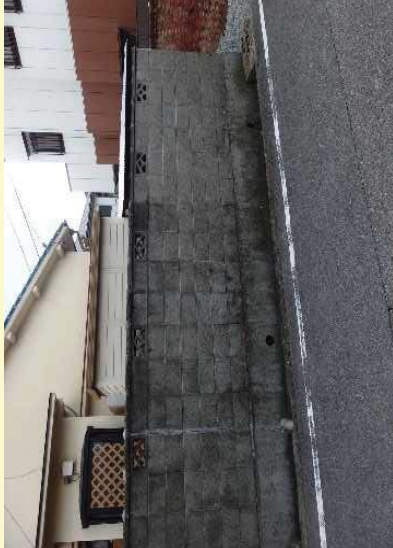
ブロック塀等の 除却等を実施
