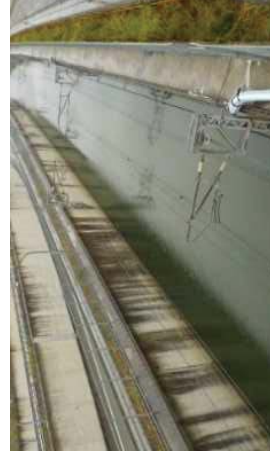
浸水した関空アクセス鉄道の線路
