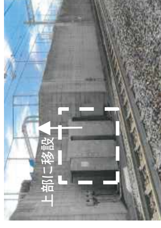
対策例 : 電気設備の移設
