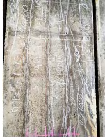
床版下面（中空床板橋）のひびわれ
