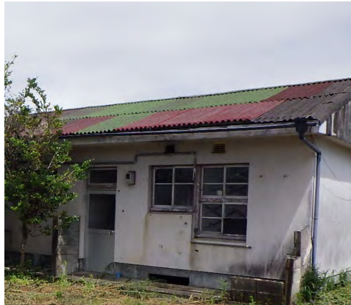
(建替前)老朽化した市営住宅
