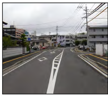
写真③ 道路整備状況
