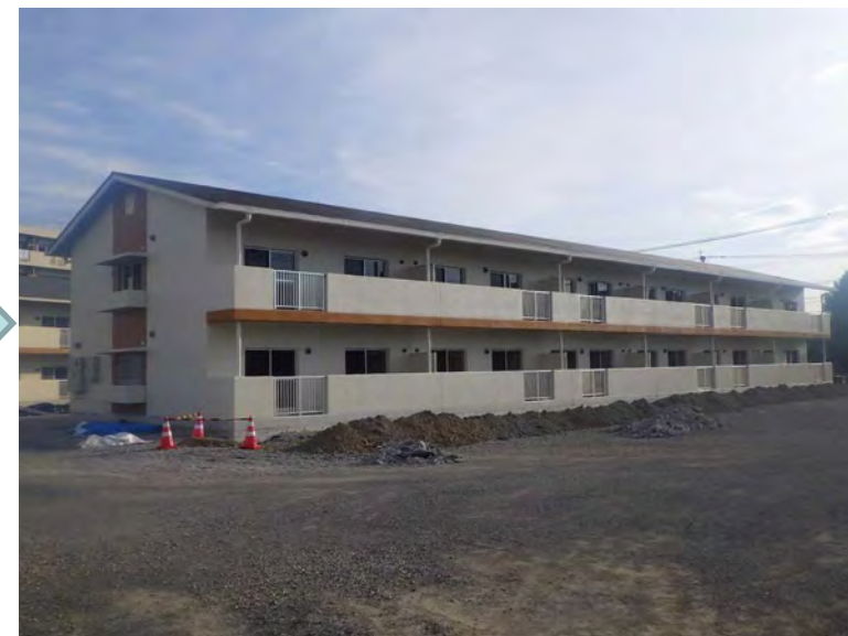
(建替後)同団地他棟の事例
