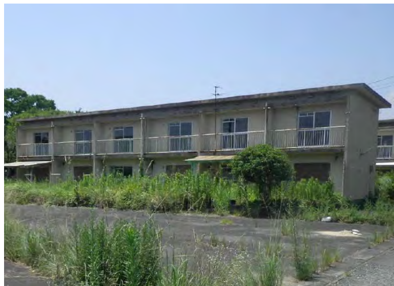
(建替前)老朽化した市営住宅
