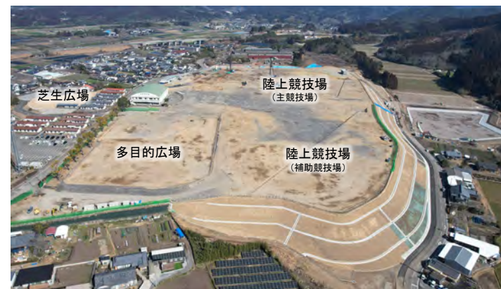
▲施工状況写真(令和4年2月末時点)
