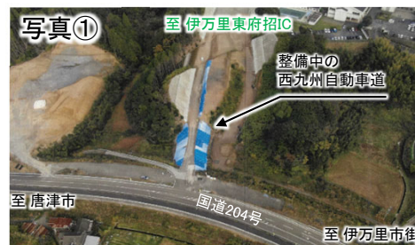
▲IC整備による交差点の新設
