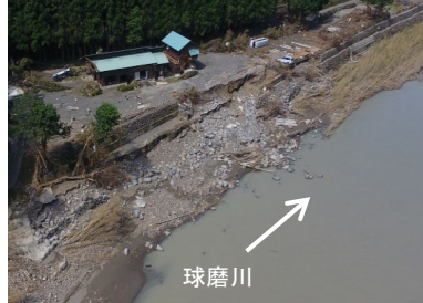
▲球磨川(52.0k付近)における護岸の被害状況(球磨郡球磨村)
