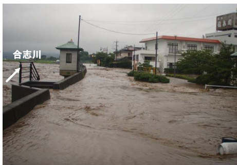
植木温泉街に流入する氾濫流 (山城堰下流右岸) H24.7.12
