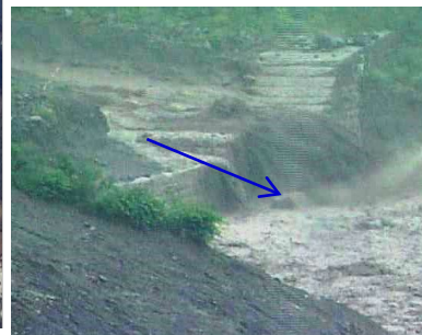
赤松谷川上流で発生した土石流(H27年6月)
