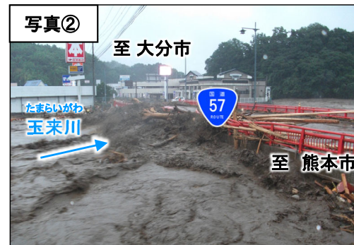
▲ H24.7 九州北部豪雨の被災状況
