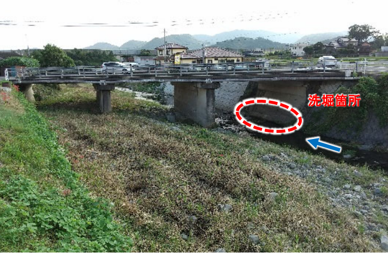
洗掘防止箇所(全景)
