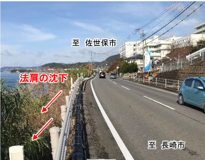
法面对策箇所(全景)
