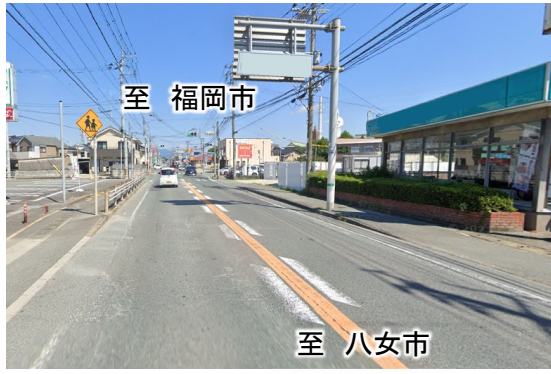
舗装修繕箇所(全景)
