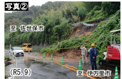
国道204号法面崩壊の状況 (提供：長崎県)
