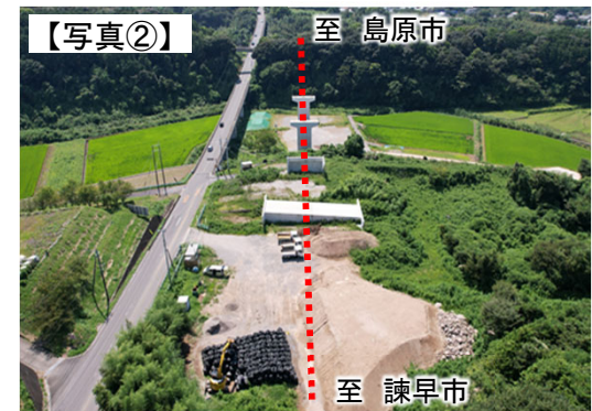
▲ 瑞穂IC～吾妻東IC間の工事状況
