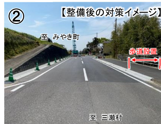
▲ 歩道の設置により、安全な歩行空間を確保
