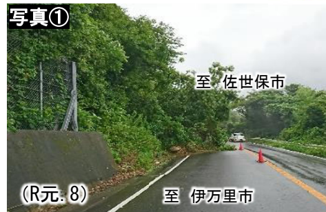
国道204号法面崩壊の状況 (提供：長崎県)
