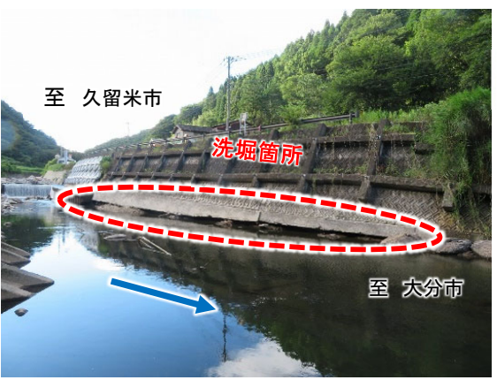
洗掘防止箇所(全景①)
