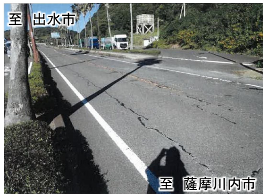
舗装修繕箇所(全景)
