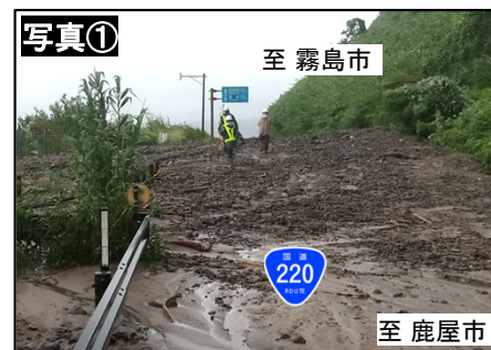
▲ R4.9 国道220号への土砂流入
