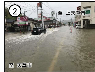
▲国道266号(現道)大雨による冠水
