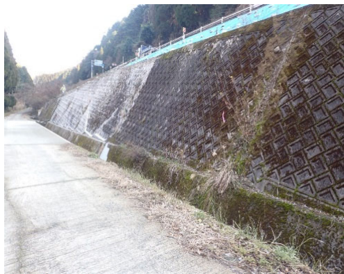
法面对策箇所(全景)
