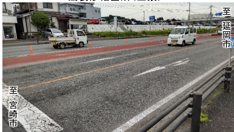
舗裝修繕箇所(全景)
