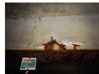
上部工下面 鉄筋腐食状況
