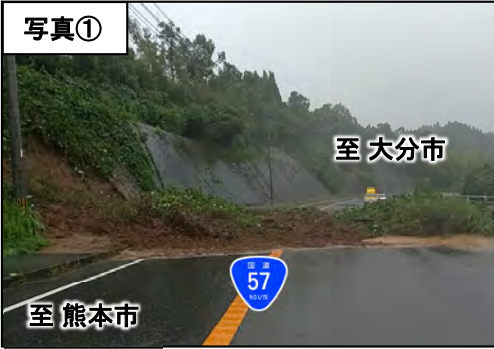
▲ R4.9 台風14号の被災状況
