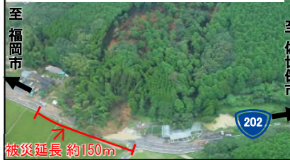
《地すべり災害被災状況写真(H18.9)》
