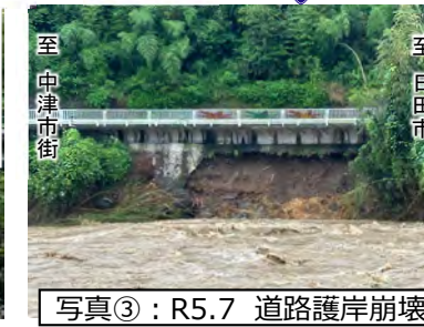
写真③：R5.7 道路護岸崩壊
