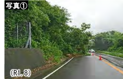
▲国道204号法面崩壊の状況（提供：長崎県）
