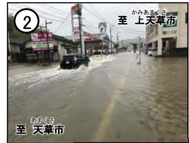
▲ 国道266号(現道)大雨による冠水
