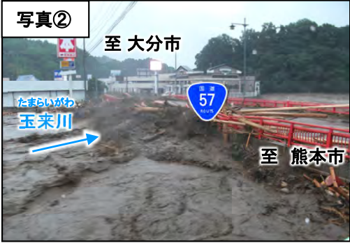
▲ H24.7 九州北部豪雨の被災状況
