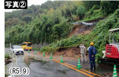
▲国道204号法面崩壊の状況（提供：長崎県）
