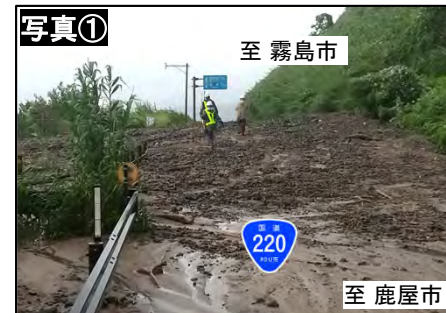
▲ R4.9 国道220号への土砂流入
