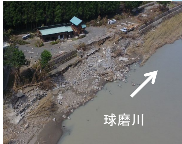
▲球磨川(52.0k付近)における護岸の被害状況(球磨郡球磨村)
