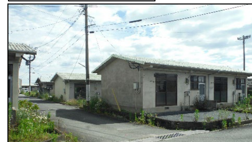
老朽化した市営住宅
