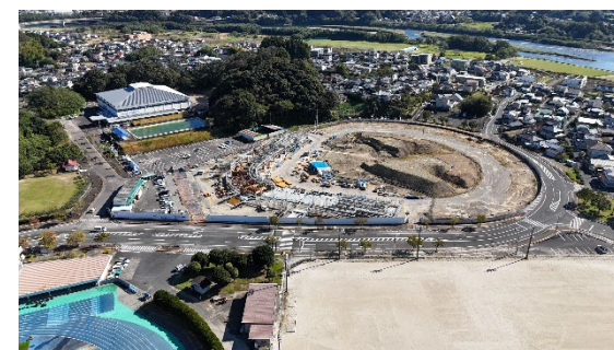
状況写真(令和6年11月)西側より
