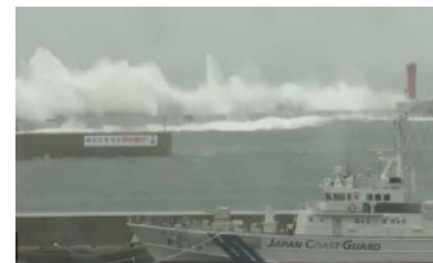
厳原地区 防波堤(北)
